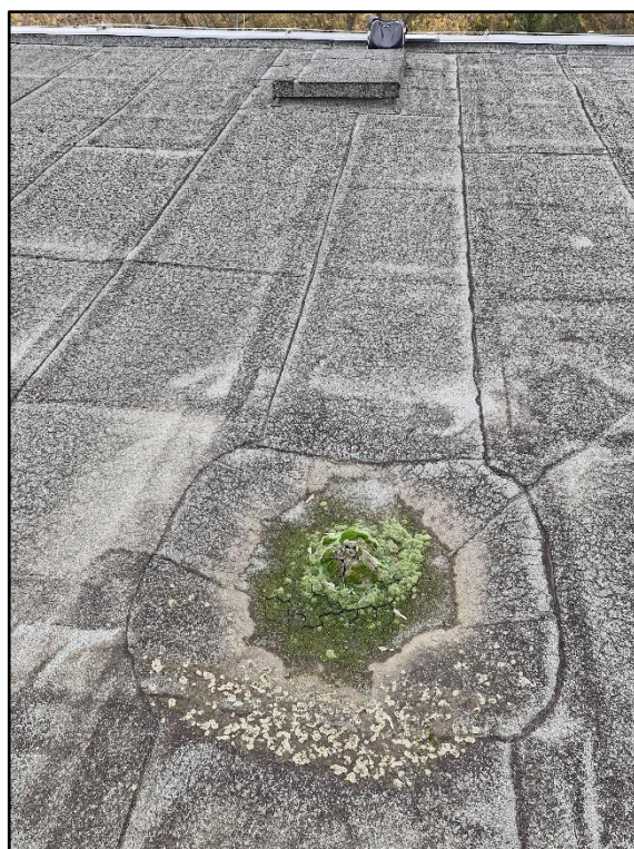
Obr. č.4 – střecha „A“ - střešní vtok a původní konstrukce výlezu
