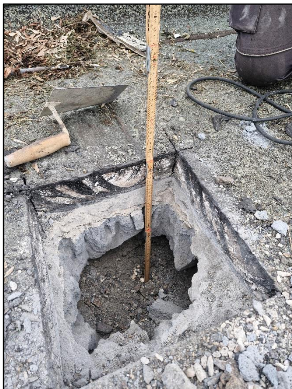
Obr. č.9 – střecha „B“ - sonda so střešního pláště
