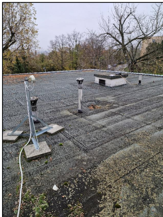
Obr. č.6 – střecha „B“ - větrací šachta, odvětrávací komínky, konstrukce antény
